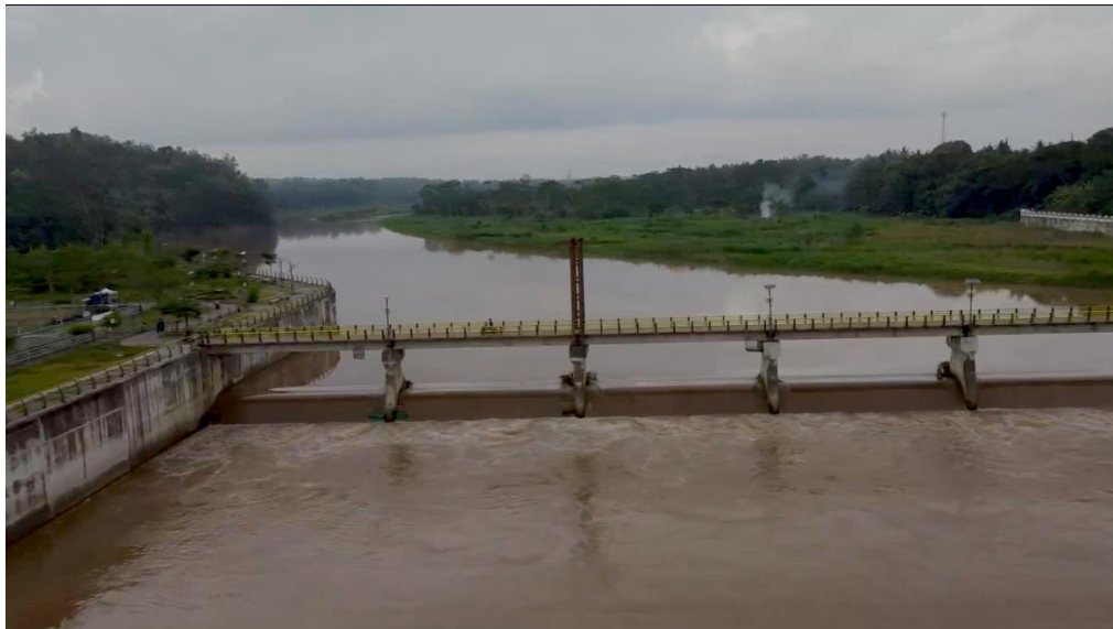
Gambar 2. Jembatan pada Bendungan Kamijoro (Sumber: Dokumentasi Pribadi)
